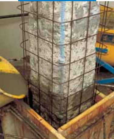
Заливка в опалубку
