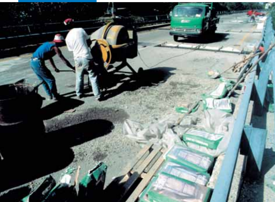
Формирование дорожных швов
