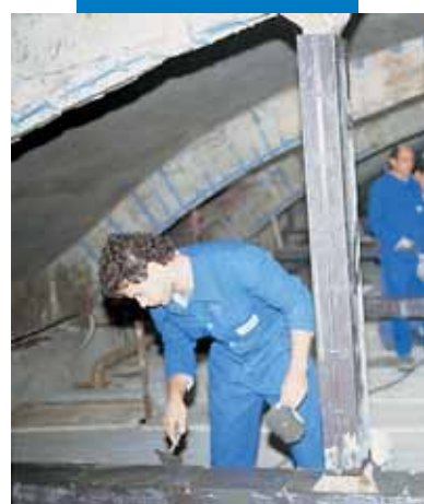
Заливка Mapegrout Hi-Flow в металлическую опалубку
